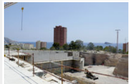
Inicio de las obras en el solar que albergará al edificio Intempo.
